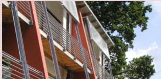
Architekt Hariolf Brenner, Aalen (Reihenhaus)
